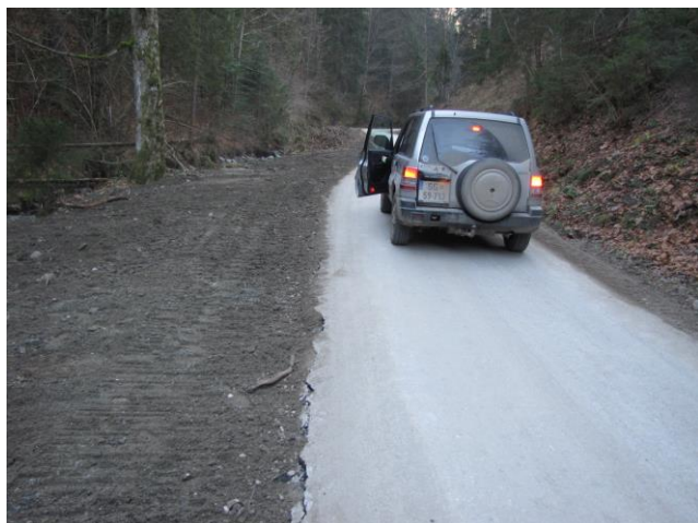
Pogled na interventno dosuto cesto iz PR 39 gorvodno in dolvodno, prelivanje je poškodovalo rob vozišča , brežino je potrebno stabilizirati z kamnito betonsko oblogo
