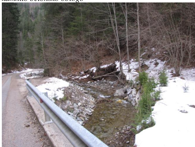
Pogled gorvodno iz PR 43, kjer je bila interventno dograjena brežina in del porušene ceste, brežino je potrebno stabilizirati z kamnito betonsko oblogo
