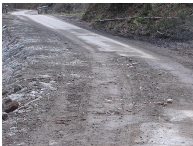
Pogled gorvodno iz PR 43, kjer je bila interventno dograjena brežina in del porušene ceste, brežino je potrebno stabilizirati z kamnito betonsko oblogo
