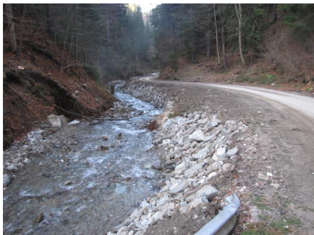
Pogled na poškodovano strugo in interventno dograjeno iz PR 52 proti PR 58 gorvodno in pogled dolvodno
