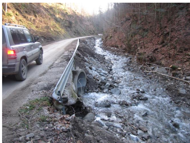
Pogled na poškodovano brežino ceste, katera je interventno dosuta, brežino je potrebno stabilizirati z kamnito betonsko oblogo.
