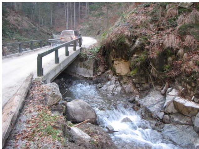
Prepust v PR 66 je popolnoma »zabilo« ima ustrezno prevodnost brez varnostne višine, to pa ima za posledico zatikanje raznih naplavin, prepust je potrebno očistiti, niveleto struge pa poglobiti za cca 50cm nekaj metrov gorvodno in dolvodno.
