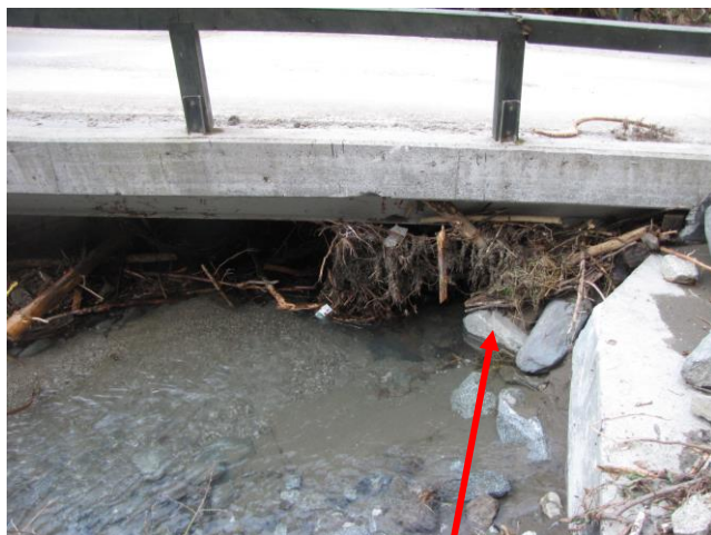
Prepust v PR 66 je popolnoma »zabilo« ima ustrezno prevodnost brez varnostne višine, to pa ima za posledico zatikanje raznih naplavin, prepust je potrebno očistiti, niveleto struge pa poglobiti za cca 50cm nekaj metrov gorvodno in dolvodno.
