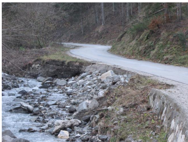
Pogled z preusta- projektiranega cestnega profila PR 11+5m, vidno je da struga zajedla v brežino do roba asfalta in od tukaj naprej prelivala cesto, zaradi dviga dna in zamašitve prepusta.
