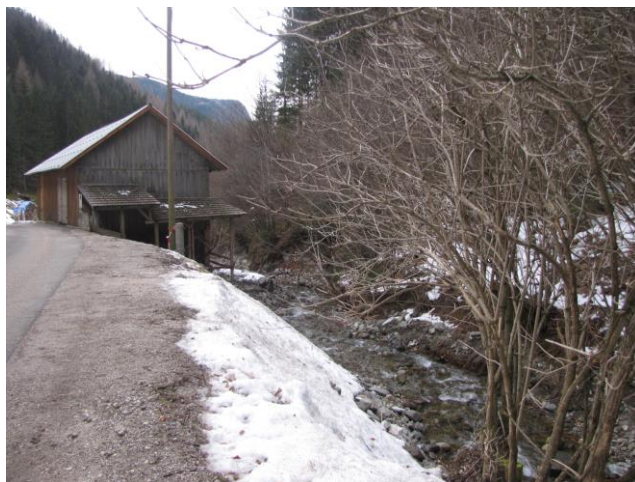
Lastnik je delno stabiliziral objekt, v tem območju je predviden obojestranski kamnito betonski zid v dolžini 40m PR 29,30
