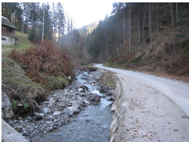
Pogled z preusta- projektiranega cestnega profila PR 11+5m, vidno je da struga zajedla v brežino do roba asfalta in od tukaj naprej prelivala cesto, zaradi dviga dna in zamašitve prepusta.
