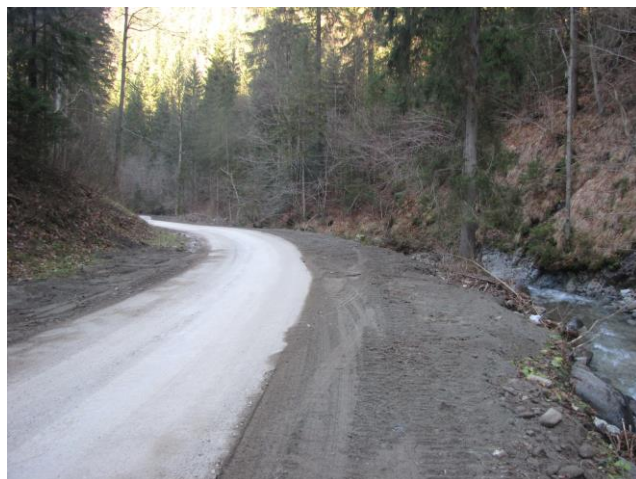
Pogled na interventno dosuto cesto iz PR 39 gorvodno in dolvodno, prelivanje je poškodovalo rob vozišča , brežino je potrebno stabilizirati z kamnito betonsko oblogo
