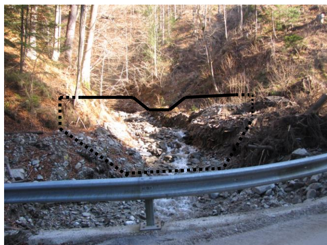
Pogled na hudourniško grapo v PR 58, kjer naplavina prelila cesto z raznimi naplavinami, na tem mestu je predviden nov prepust izza njega pa manjša kamnito betonska pregrada.
