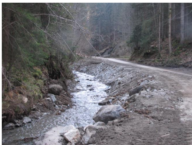
Pogled gorvodno iz PR 43, kjer je bila interventno dograjena brežina in del porušene ceste, brežino je potrebno stabilizirati z kamnito betonsko oblogo
