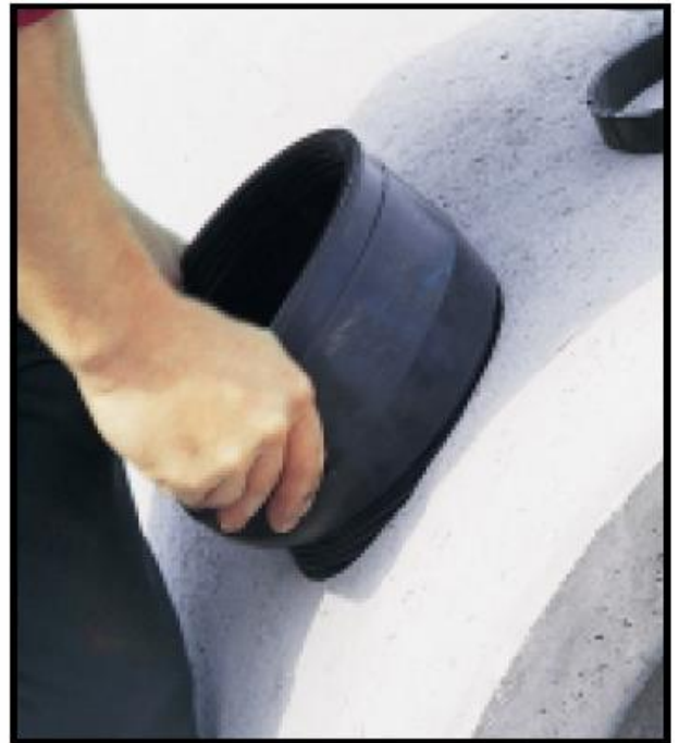
rechts: Einsetzen des Anschlussstutzens
