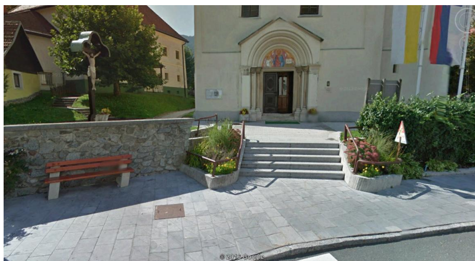
Plošče iz pohorskega tonalita in kocke v ožjem središču - tlakovanje, ki ga uporabimo na ulici ob potoku
