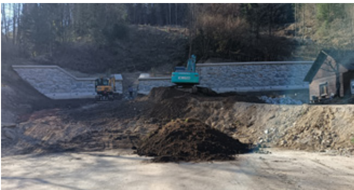
Sanacija plazu Pristava.
