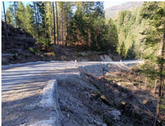
SANACIJA CESTE LC 257011 MEŽICA Podkraj.
