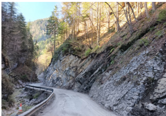
Potek del na stabilizaciji podpornih opornih zidov in rekonstrukciji ceste LC 257011 Podpeca.
